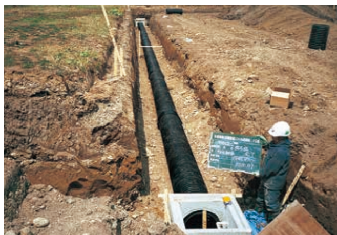
小排水路の管路化工事
