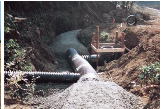
土捨場防災暗渠工事
