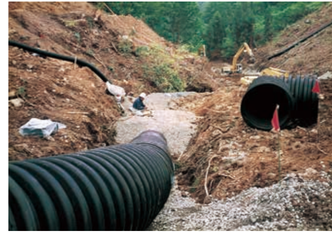
土地造成防災暗渠排水工事
