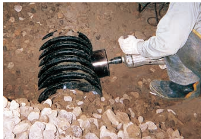
トンネルセンタードレン ゴム支管用穴開け作業
