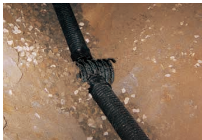
トンネルセンタードレン横断管接続
