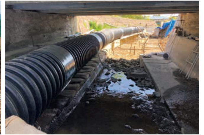
河川改修排水工事
